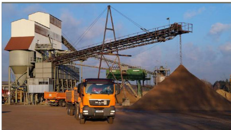
Nassaufbereitungsanlage; Foto: © Mineralix GmbH
